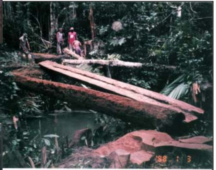
Durante construção da estrada pequenas pontes foram feitas para superar os obstáculos naturais.
