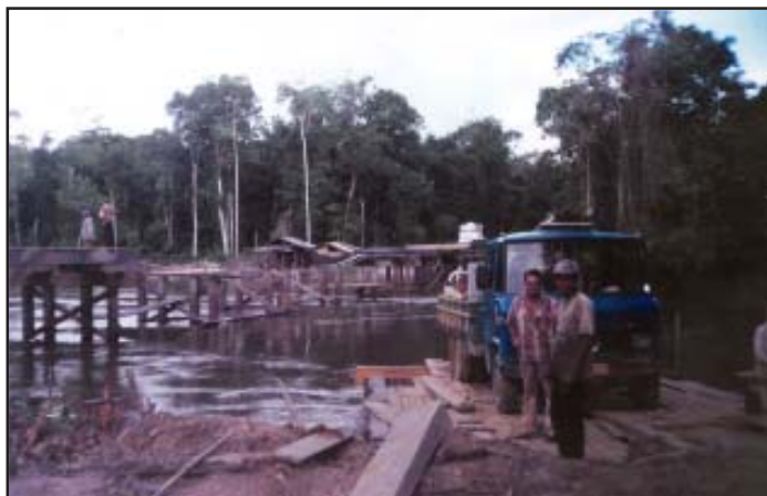
Ponte sobre o rio Jaci construída pelos camponeses de Jacinópolis em 2003
